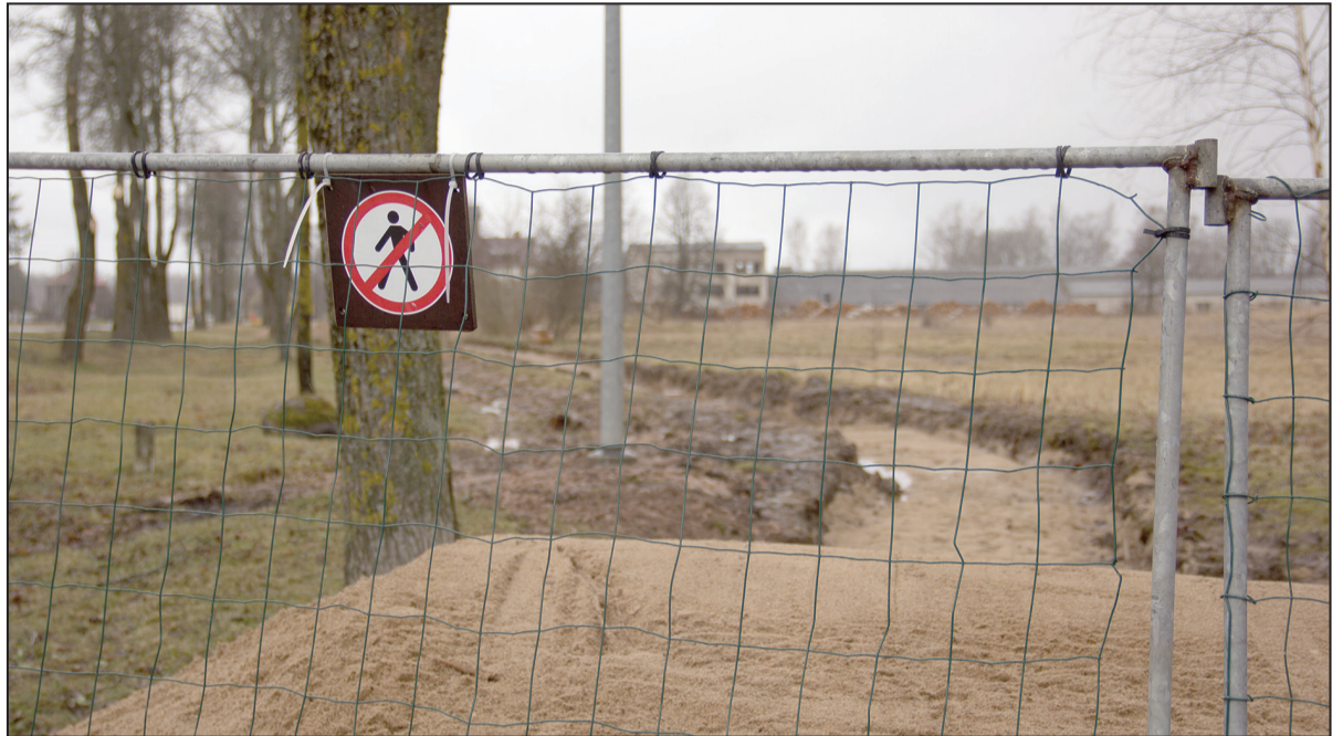
Kuldīgas ielas posmā no Kalēju ielas līdz dzelzceļa pārbrauktuvei izbūvē gājēju celiņu.
