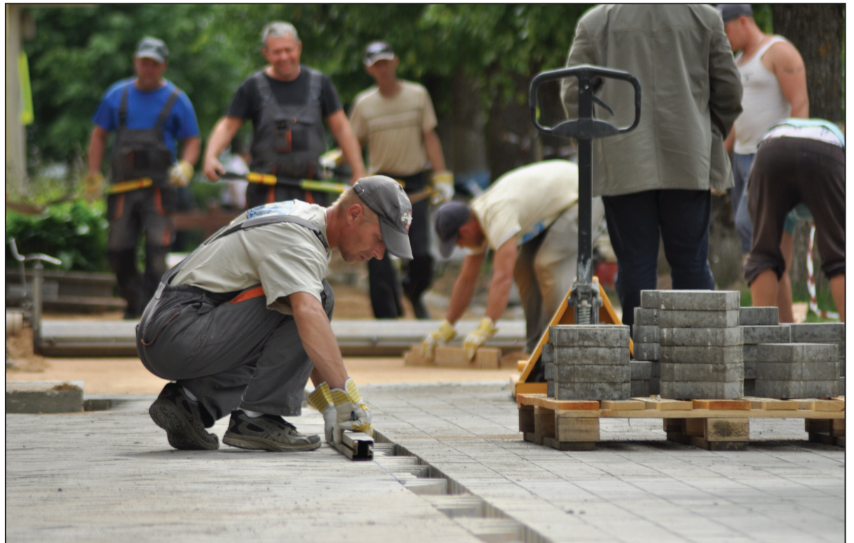
SIA "AVA" darbinieki rekonstruē gājēju ietvi Liepājas ielā.
