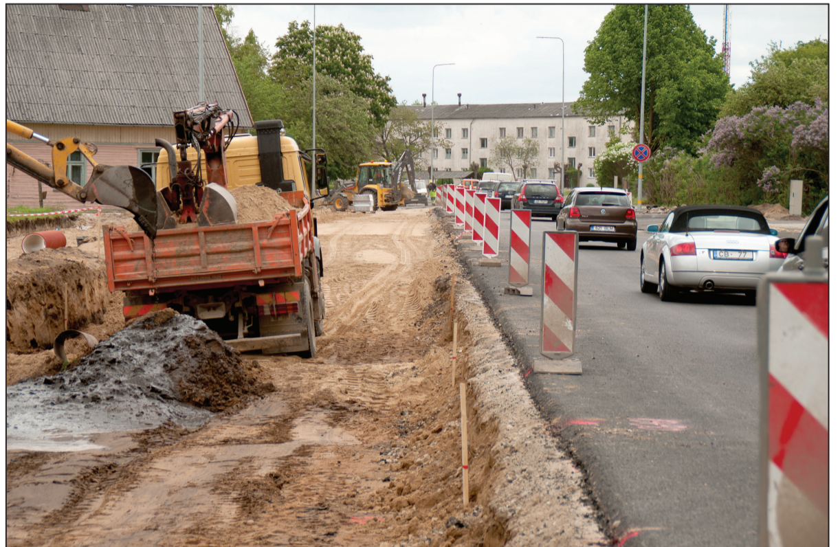
Rekonstrukcijas darbi Rīgas - Liepājas šosejas Skrundas posmā tuvojas noslēgumam.
