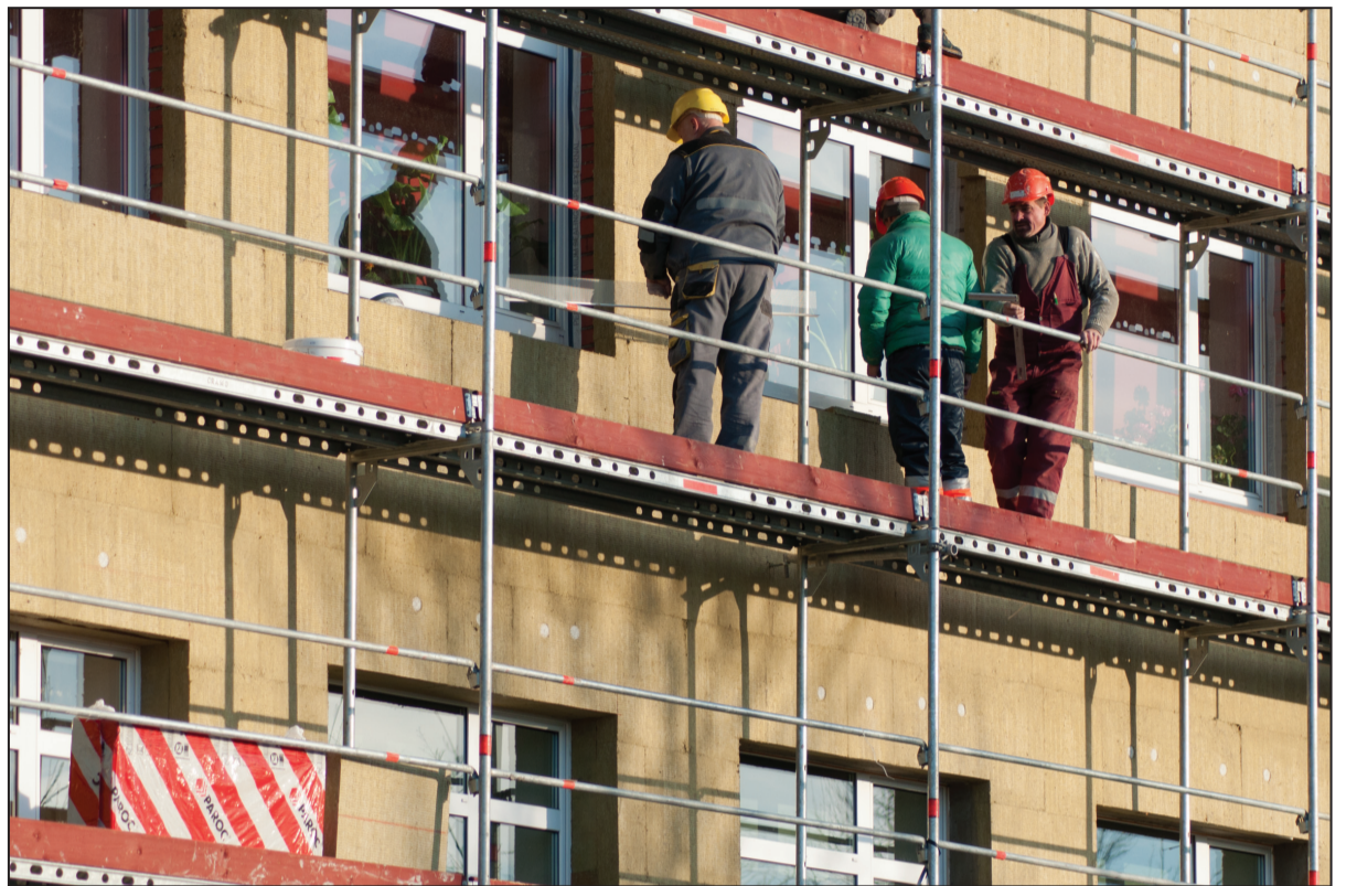
SIA "Prepils" darbinieki veic siltināšanu Skrundas vidusskolas ēkai.
